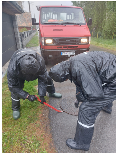
Kontrola splaškovej kanalizácie
